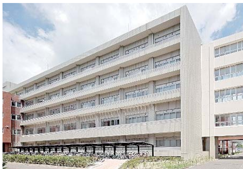
省エネを踏まえた改修建物 (H27年度 医学部臨床研究棟)
